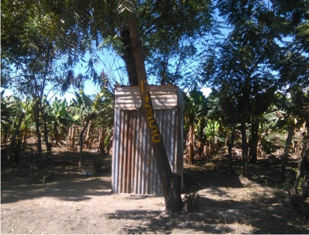
Afectación 6: Letrina con paredes y techo de zinc
